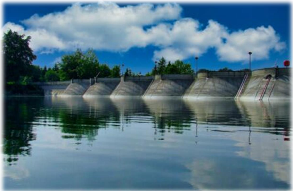
De dam werd aangelegd van 1929 tot 1932, is 140 m lang en heeft een hoogte van 23 meter. De centrale kan jaarlijks ongeveer 2,2 miljoen kWh energie leveren en wordt uitgebaut door Electrabel.
